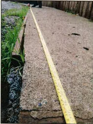
Foto N° 1: Junta de dilatación mayor a 2[m].
