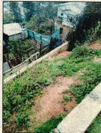
Foto N° 4: Falta de instalación de geotextil y arena compactada limpia.
